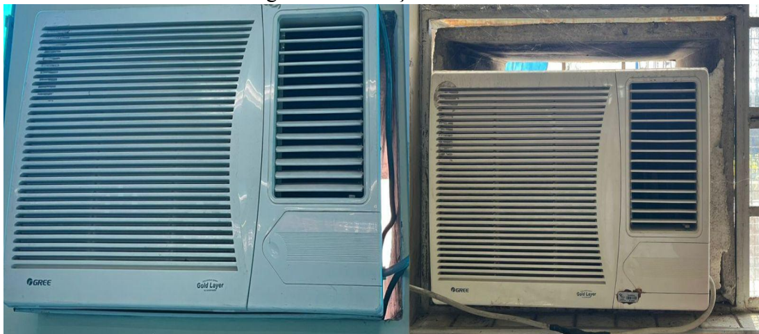
Figura 14 - Vedação Deficiente
