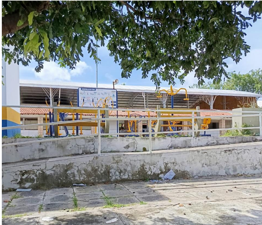
Figura 6 – Fotografia diurna da academia ao ar livre do Mercado do Gurupi localizada no entorno na comunidade Alto da Ressurreição
