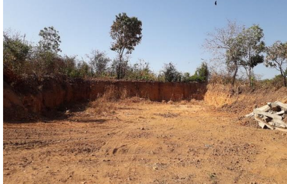
Figura 10: Terreno em início do processo de terraplanagem, com solo exposto, evidenciando a retirada da vegetação original.
