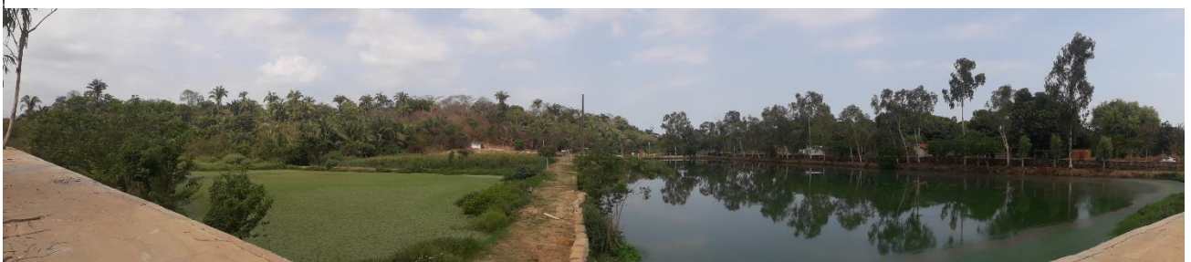
Figura 26: Estação de Tratamento de esgoto de Teresina (ETE) localizada no bairro Catarina, a ETE fica dentro de uma vasta área verde com características de vegetação nativa, à esquerda está a mata ciliar do rio Parnaíba.
