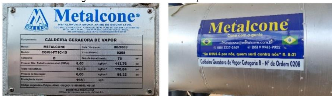
Figura 12- Placa de identificação da Caldeira.
