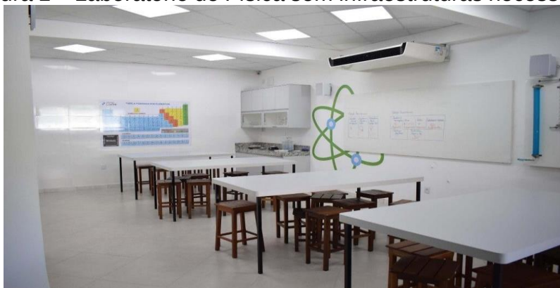
Figura 1 – Laboratório de Física sem infraestruturas necessárias.
