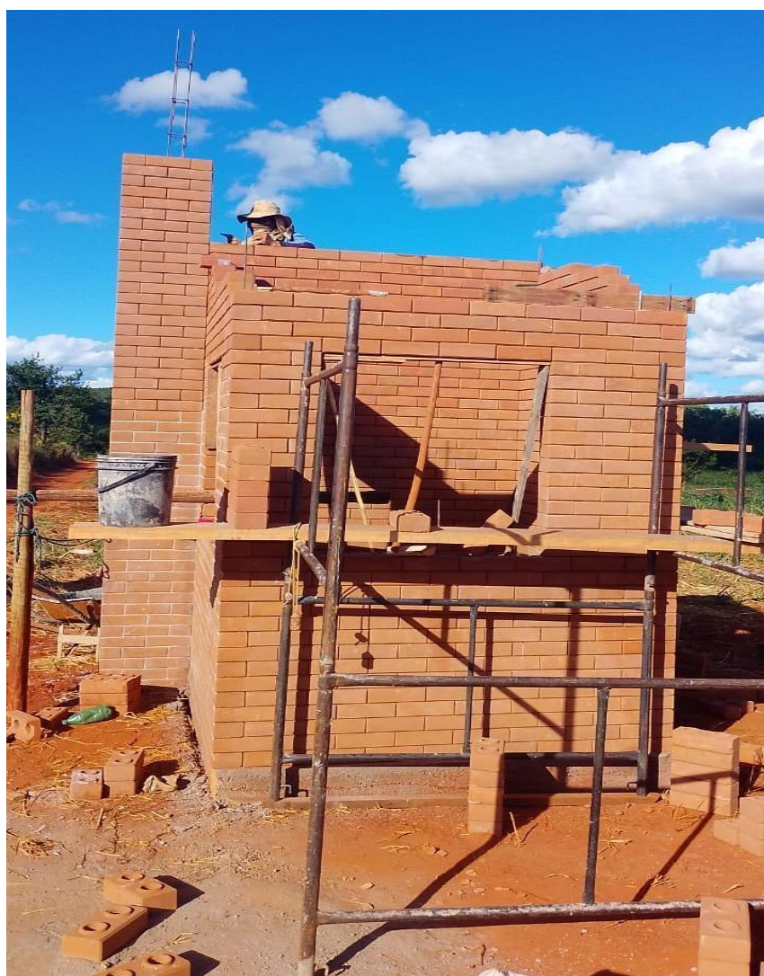
Figura 1 - Aplicação prática de tijolos de solo-cimento na construção civil
