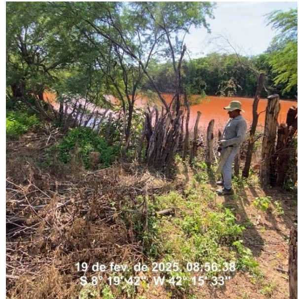
Figura 30 – Propriedade vizinha impactada pela erosão e perda de solo causada pela degradação
