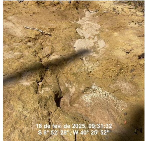
Figura 20 – Testemunho de ravinamento na área de pesquisa
