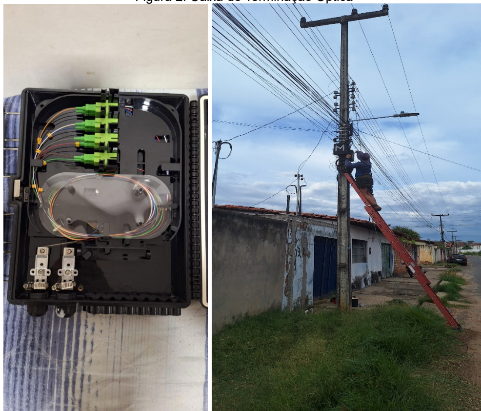
Figura 2: Caixa de Terminação Óptica
