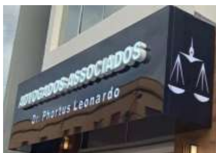
Imagem 2 - Fachada com ACM sólido e vazado.
