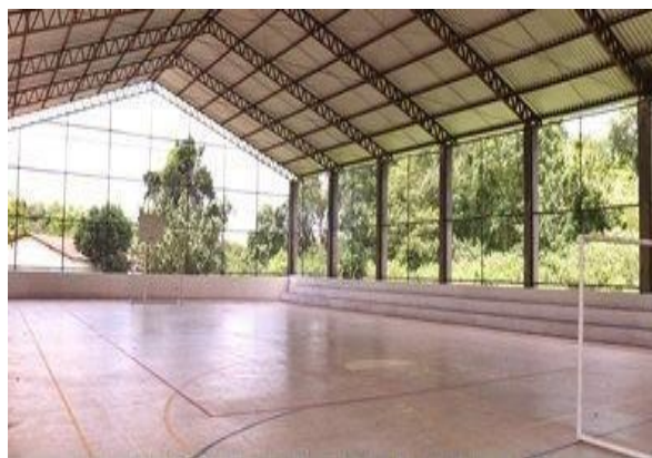
Figura 7 – Quadra coberta da escola, local onde são desenvolvidas recreações e atividades extracurriculares
