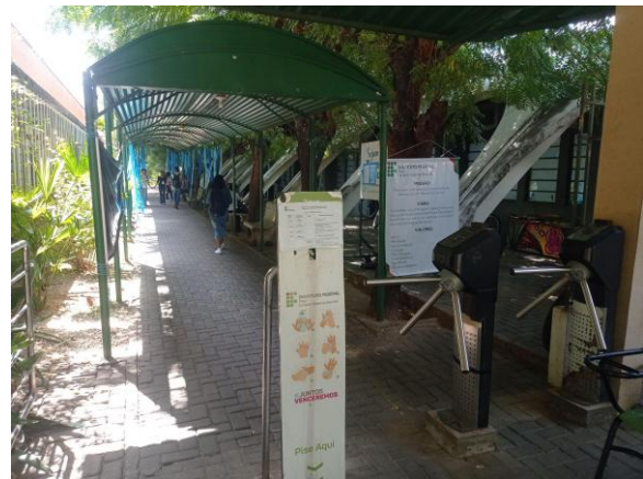
Figura 17 - Ausência de extintor na saída principal
