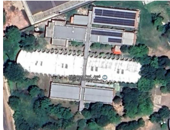
Figura 3 - Vista aérea da edificação
