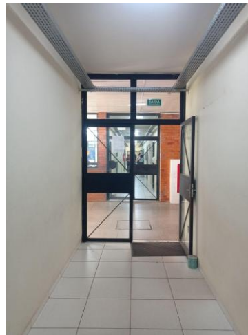
Figura 11 - Sinalização de saída de emergência conectada à circulação central
