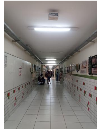
Figura 9 - Sinalização ambígua anexada ao forro, primeiro sentido
