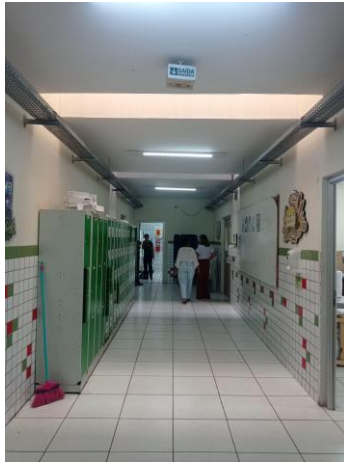
Figura 8 - Sinalização ambígua anexada ao forro, primeiro sentido
