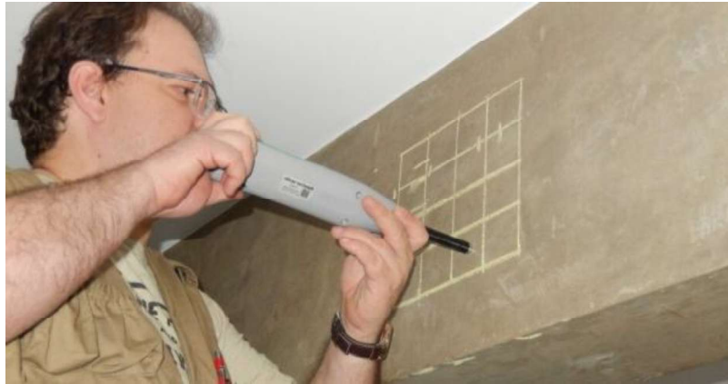
Figura 14 - Ensaio de esclerometria para estimativa da dureza superficial do concreto
