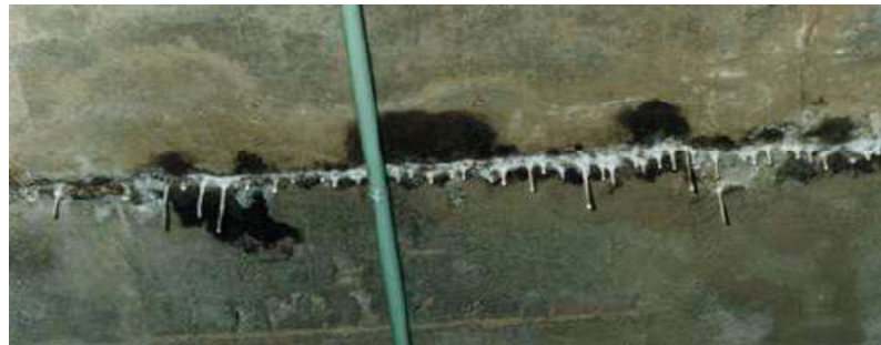
Figura 6 - Lixiviação com formação de estalactites
