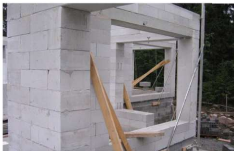
Figura 9 – Imagem de construção com BCCA
