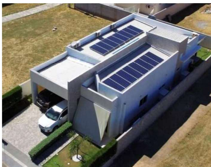
Figura 3 – Obra Residencial com placas solares fotovoltaicas
