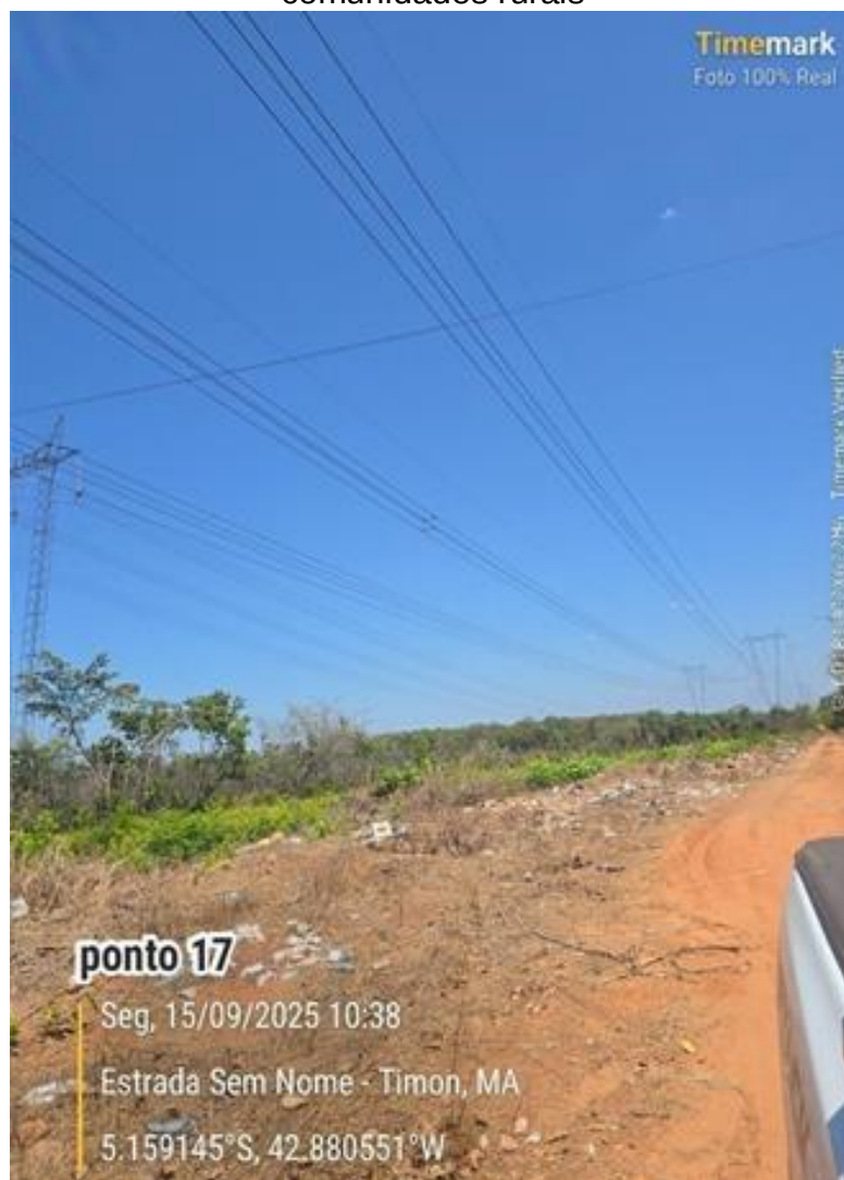
Figura 37 - Registro fotográfico da disposição irregular de resíduos próximo a comunidades rurais
