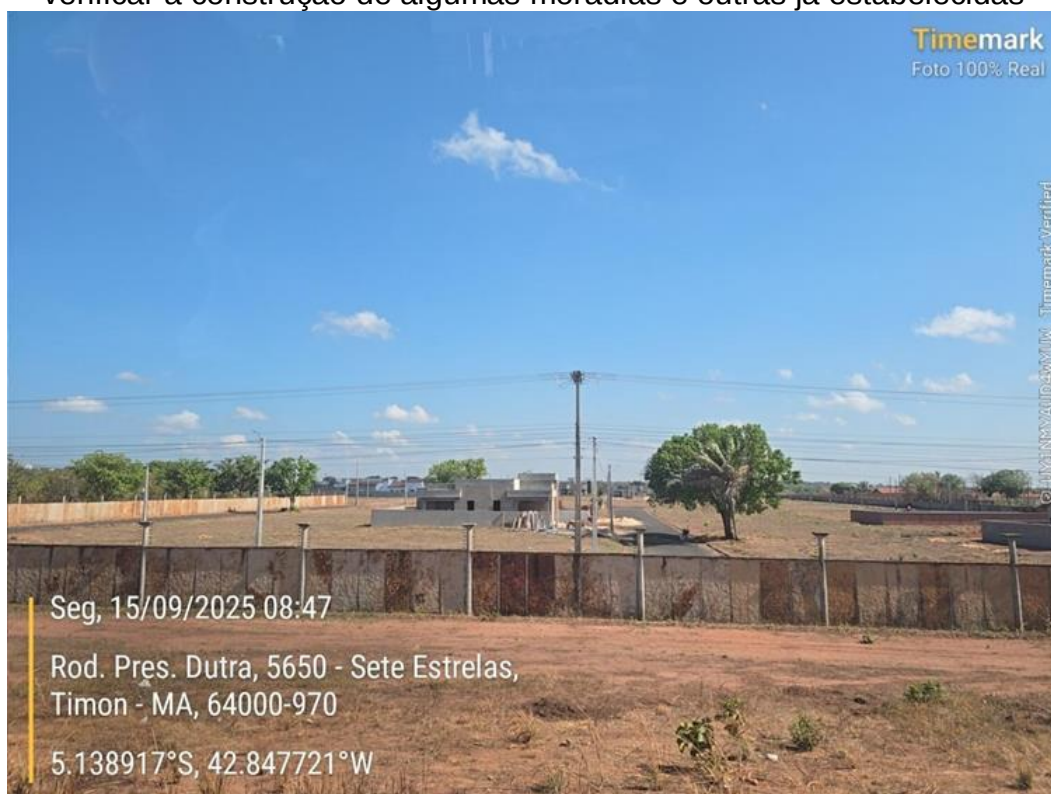
Figura 16 - Registro Fotográfico do complexo residencial Village Cajueiro, é possível verificar a construção de algumas moradias e outras já estabelecidas
