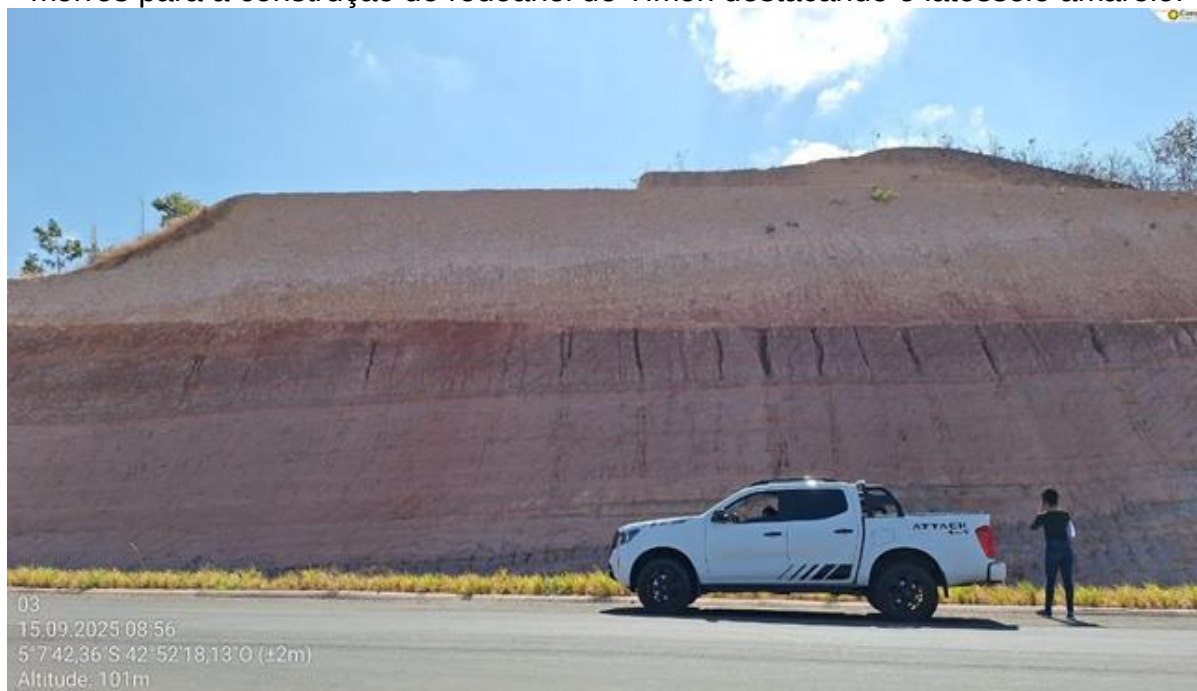
Figura 19 - Registro fotográfico da dimensão espacial dos cortes realizados nos morros para a construção do rodoanel de Timon destacando o latossolo amarelo.
