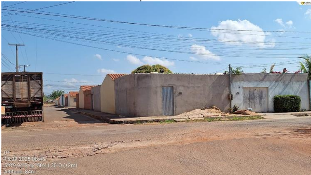
Figura 14 - Registro Fotográfico de quadras iniciais do Loteamento Emílio Falcão, entrada pela BR-226/MA
