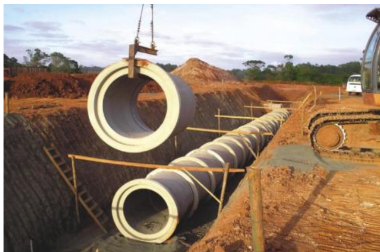
Figura 26 – Instalação de rede de drenagem
