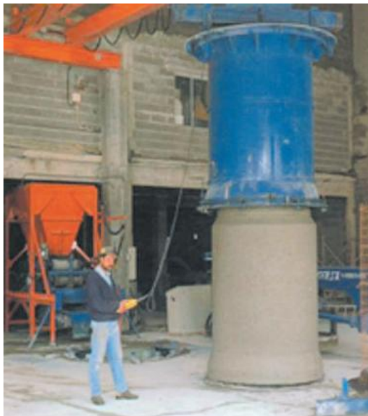
Figura 24 – Fabricação de tubo de concreto
