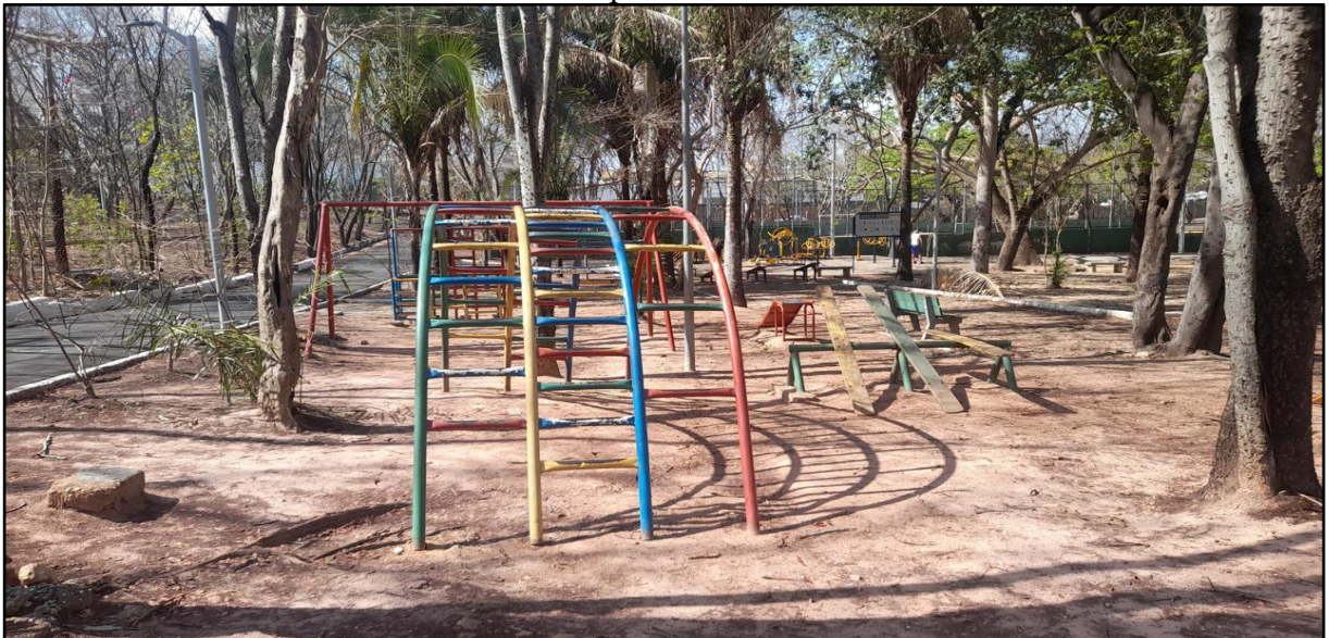
Figura 3: Deterioração do playground no Parque da Cidade, evidenciando a manutenção parcial.
