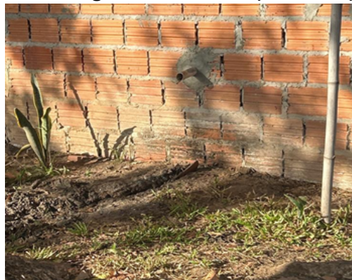
Figura 20: Encanamento das da barragem do Bezerro (Ponto 52)
