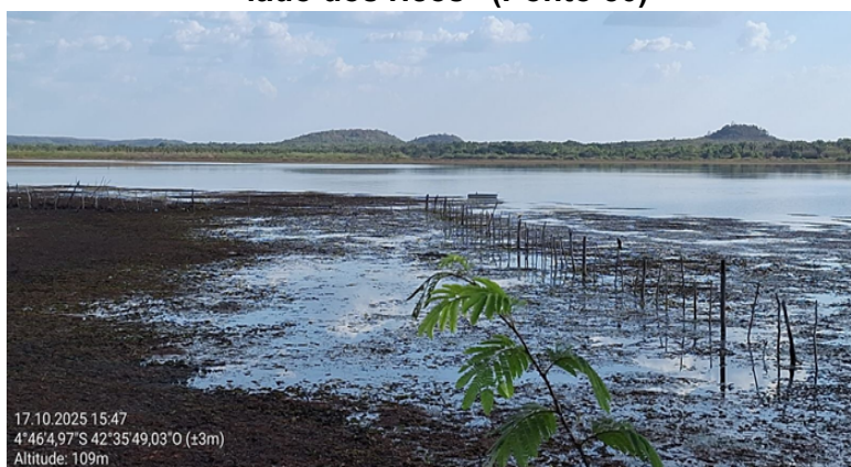
Figura 23: Margem lateral da barragem “lado dos ricos” (Ponto 50)
