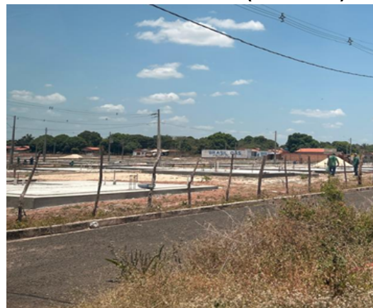
Figura 34: Casas em construção no novo loteamento (Ponto 15)
