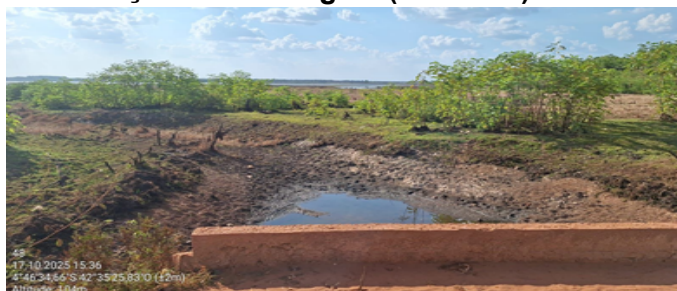
Figura 17: Local onde o sol córrego deságua no açude da barragem (Ponto 48)
