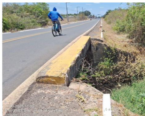
Figura 16: Vista lateral do córrego (Ponto 9)
