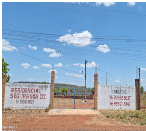
Figura 35: loteamento Segurança III (Ponto 11)
