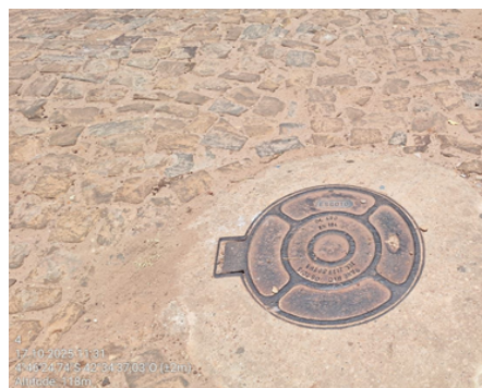
Figura 30: Tampa de bueiro (Ponto 4)
