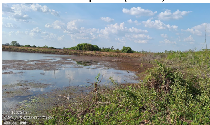
Figura 24: Margem lateral da barragem visão do paredão (Ponto 50)
