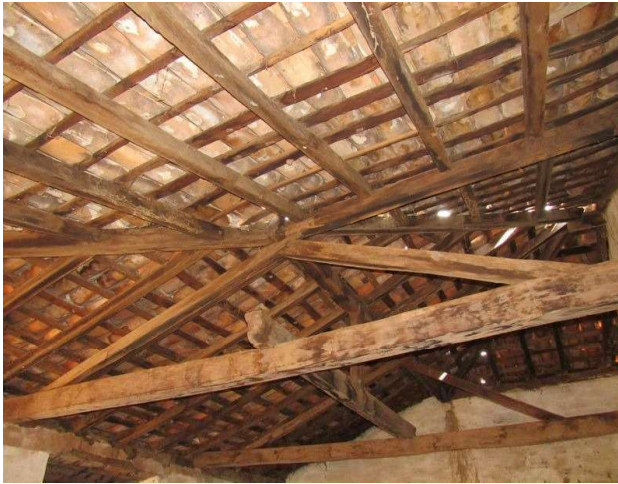
Figura 20 – Telhado da edificação
