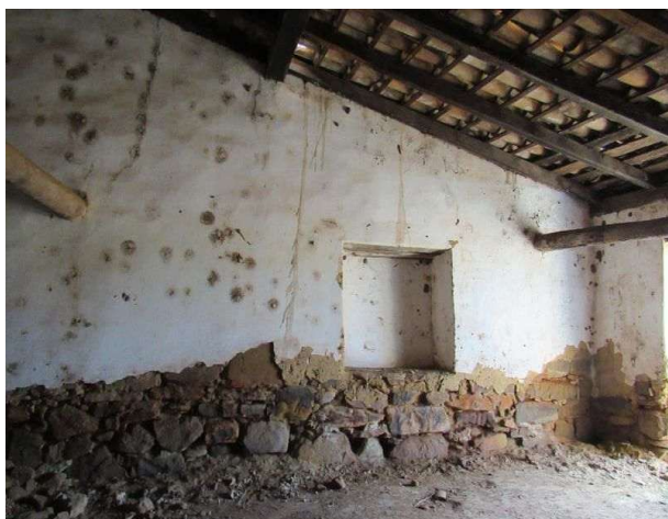
Figural 24 – Vista da parede e suas estruturas
