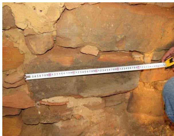
Figural 25 – Estrutura que compõe a alvenaria de pedra
