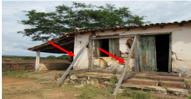
Figura 17 – Escoras nas paredes externas
