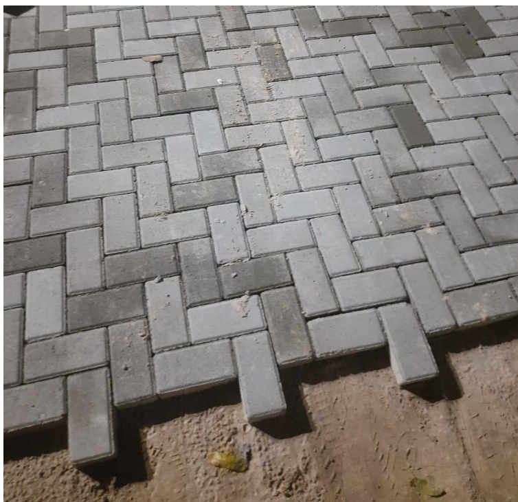
Figura 7 - Piso Intertravado da Praça
