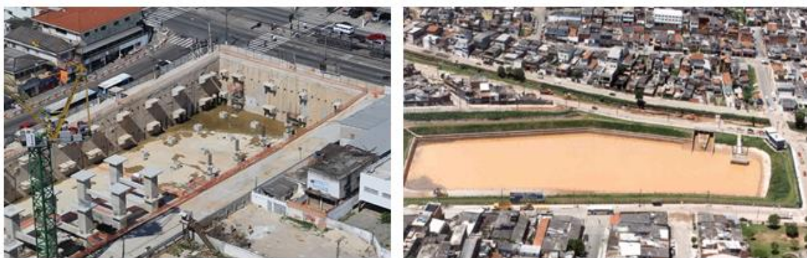
Figura 6 – Reservatórios de retenção fechado e aberto (respectivamente) em São Paulo - SP
