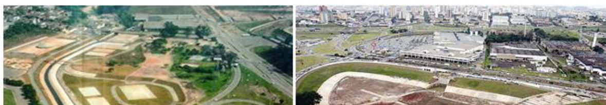
Figura 9 – Reservatórios de detenção “In-Line” e “Off-Line” respectivamente em São Paulo-SP
