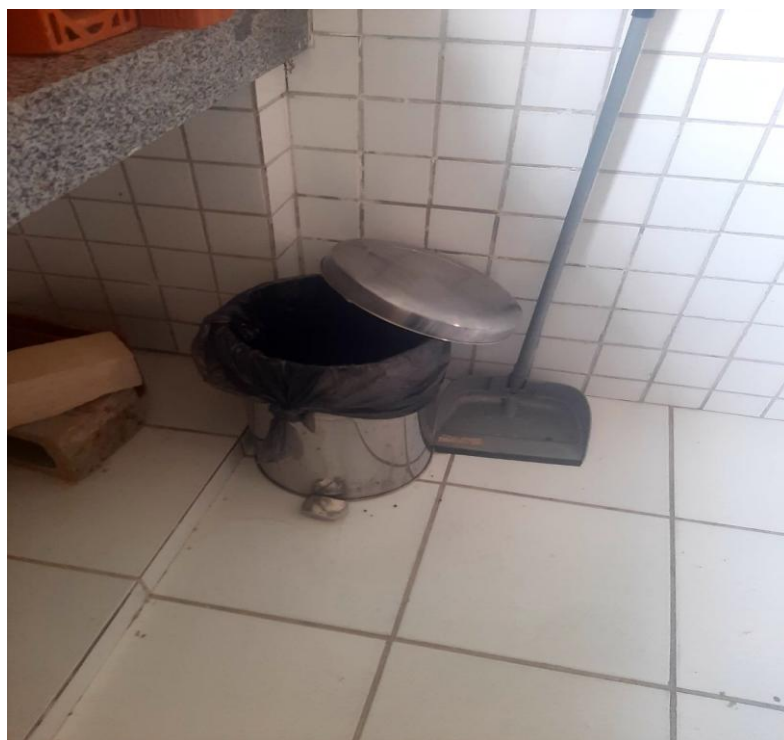
Figura 35 - Coletor do laboratório do canteiro de obras com tampa danificada.
