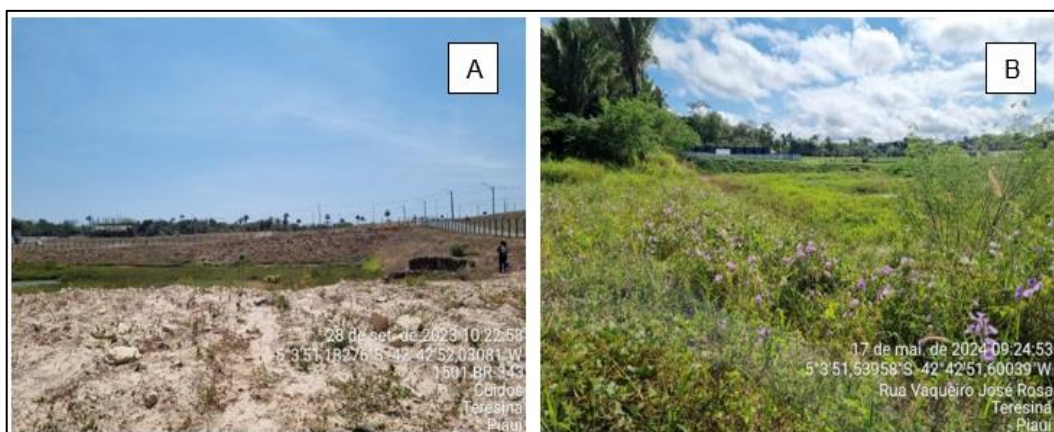
Figura 17 - Obra de drenagem em trecho do riacho na área 01 no período seco (A) e no período chuvoso (B)
