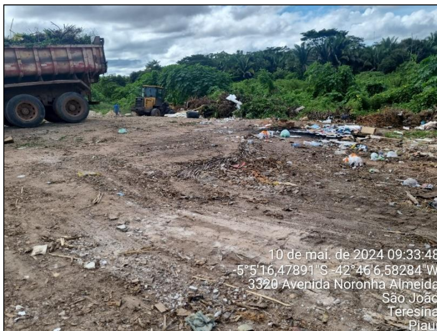
Figura 22 - Escavadeiras fazendo a raspagem do solo para retirada de resíduos na área 02
