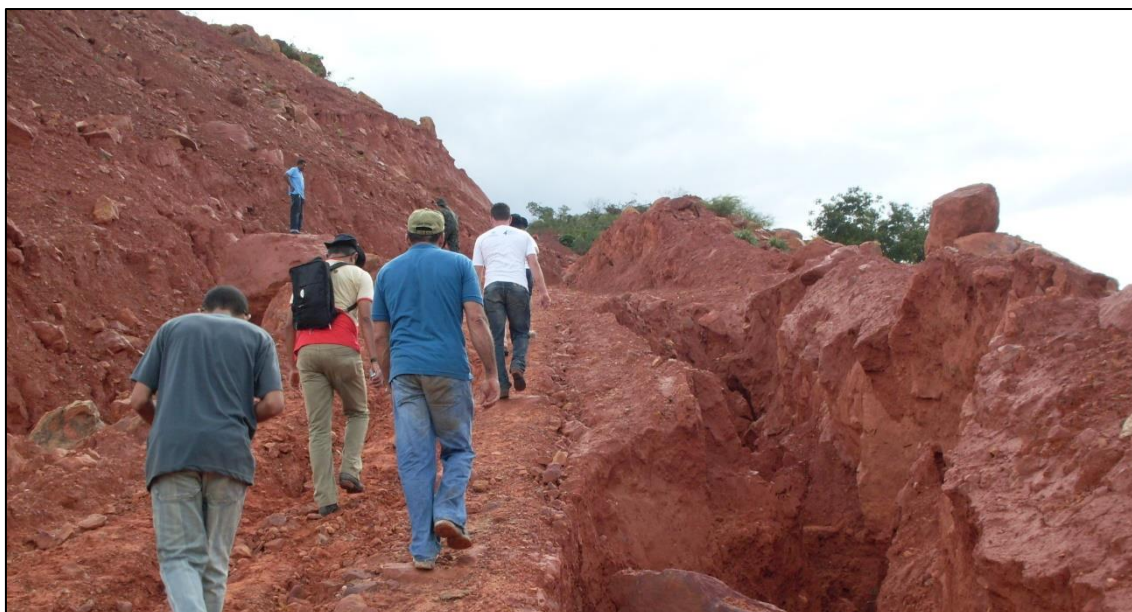
Figura 7. Trecho da obra inacabada da estrada de acesso entre o município de Corrente-PI e a Chapada das Mangabeiras.
