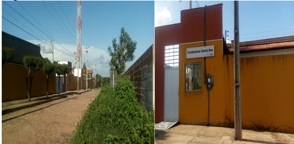
Figura 20, 22 Condomínio Santa Ana
