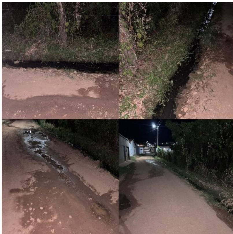
Figura 8 - Mosaico de Esgoto a céu aberto na Rua José Coelho Pita, em São João do Piauí
