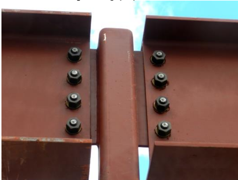
Figura 8. Ligação parafusada.
