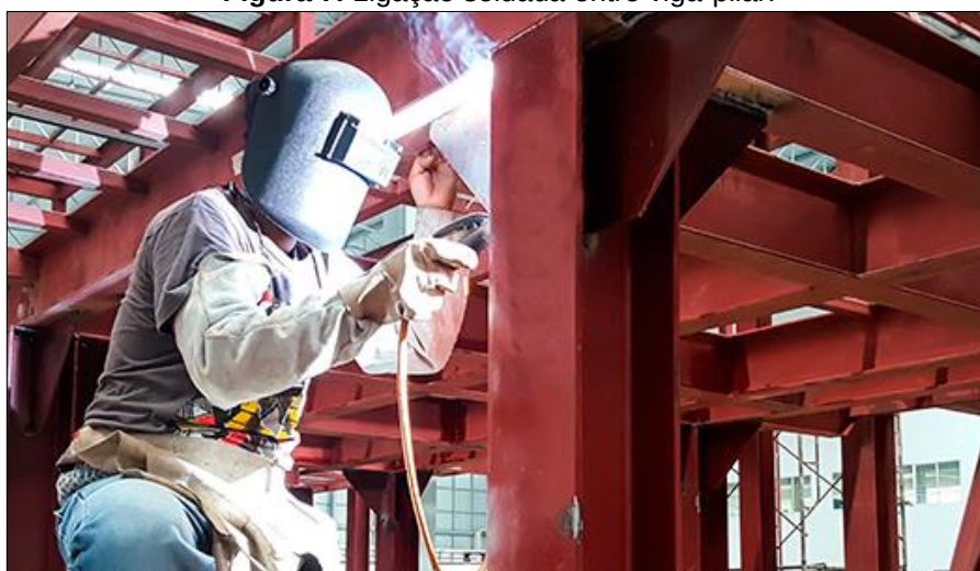
Figura 7. Ligação soldada entre viga-pilar.
