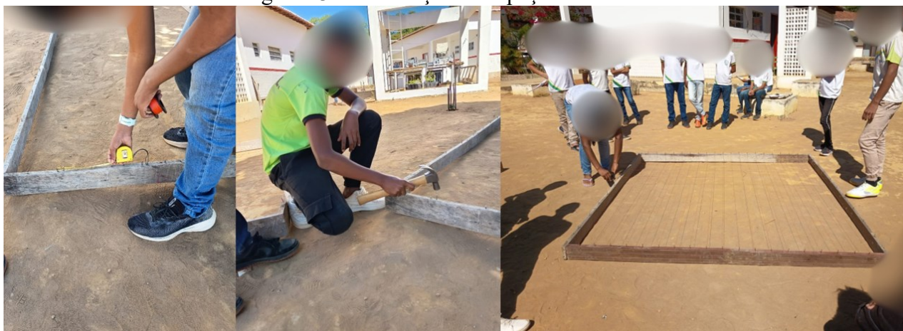
Figura 13 - Construção do espaço da horta
