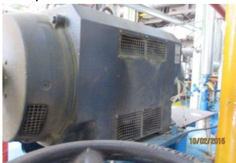
Figura 22 - Motor elétrico do Compressor Howden MK6
