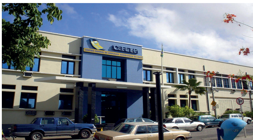
Figura 7 - Fachada da Escola 2008
