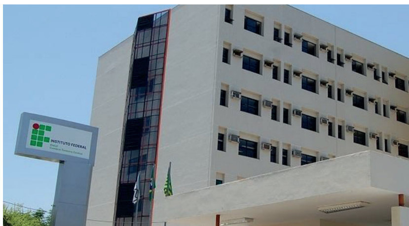
Figura 8 - Fachada do prédio B 2013
