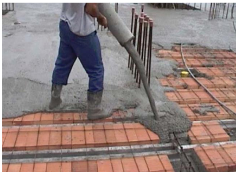
Figura 1 – Aplicação do concreto autoadensável
