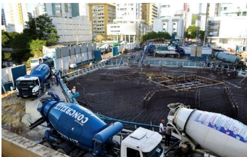
Figura 6 – Fundação do edifício Infinity Coast
