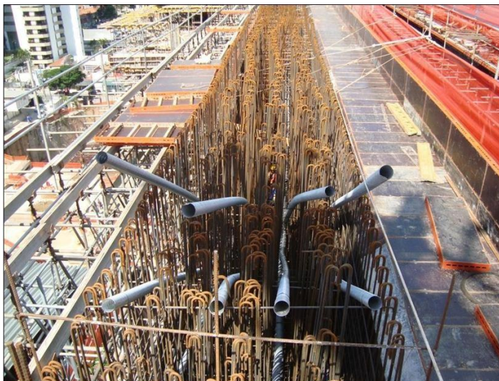
Figura 8 – Vigas “T” do Edifício Brookfield Malzoni
