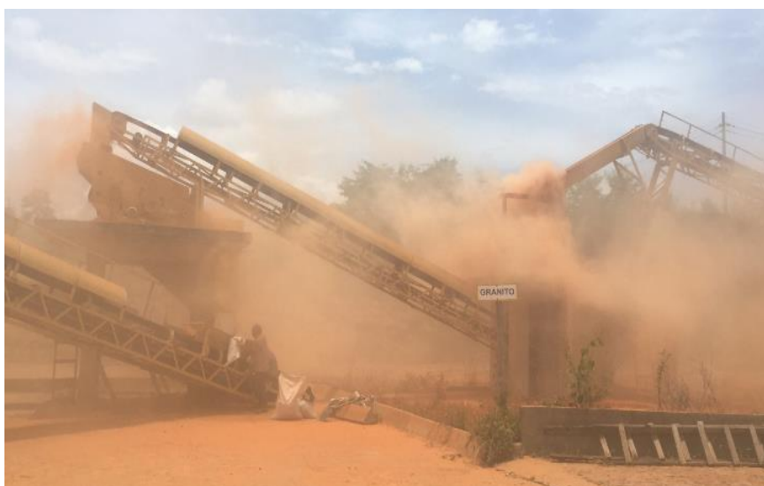
Figura 8 – Britagem do chamote cerâmico.
