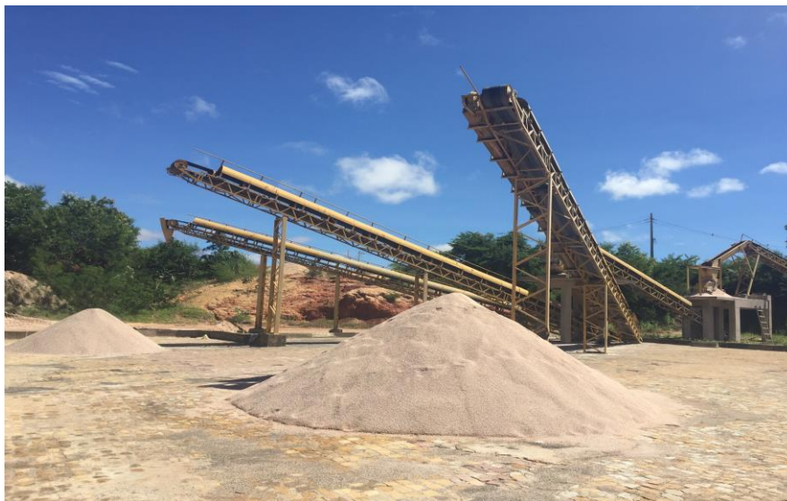
Figura 14 – Britador Faço 40x60 utilizado no processo.
