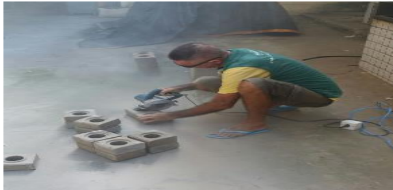
Figura 23 – Serragem dos tijolos ao meio
