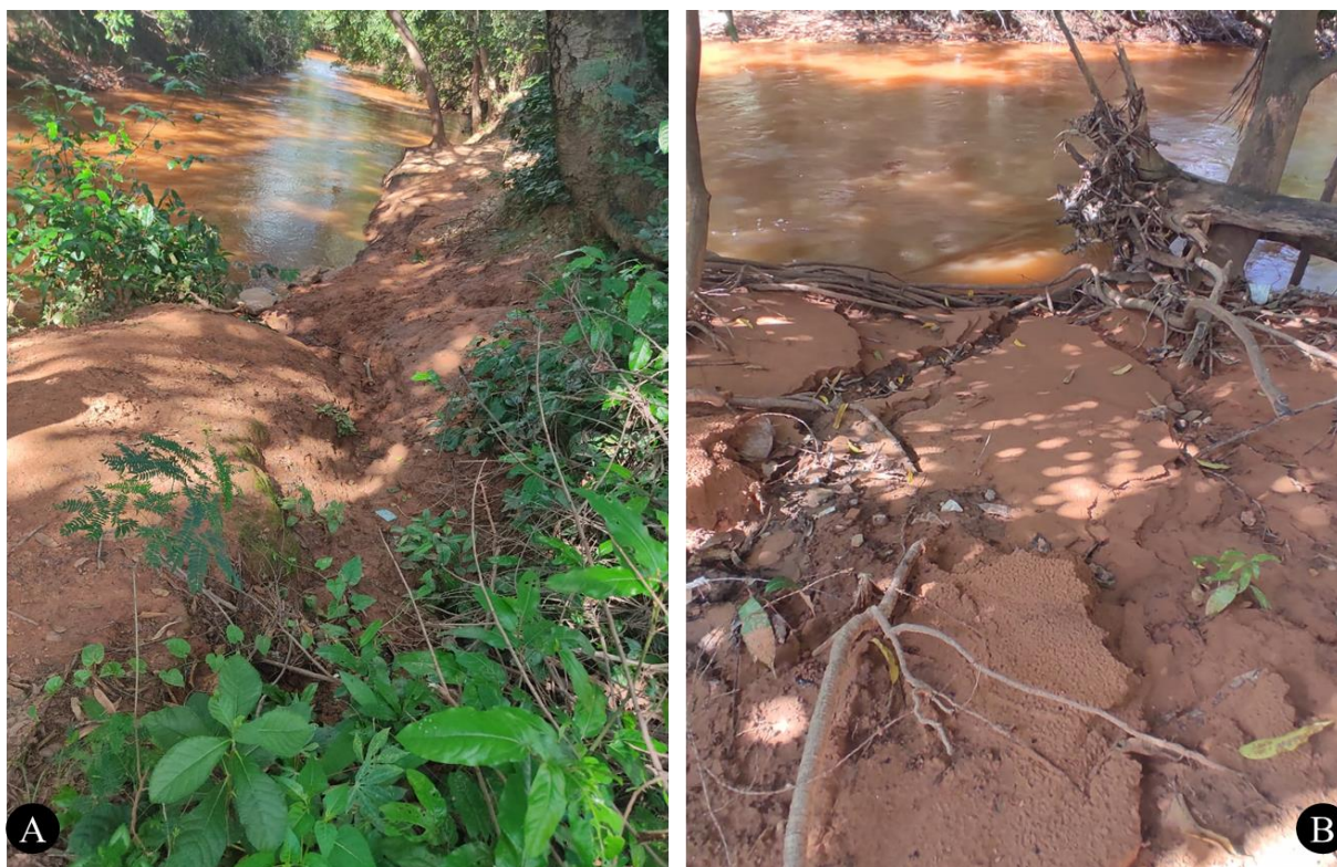
Figura 2 - Ocorrência de processo erosivo e desagregação do solo as margens do Rio Gurguéia, São Gonçalo do Gurguéia – Piauí.
