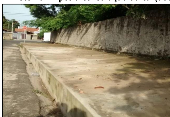
Foto 10 - Após a construção da calçada
