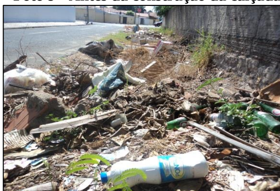
Foto 9 - Antes da construção da calçada
