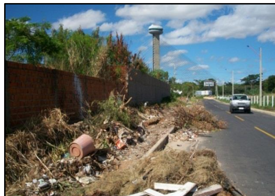
Foto 8 - Após o asfalto
