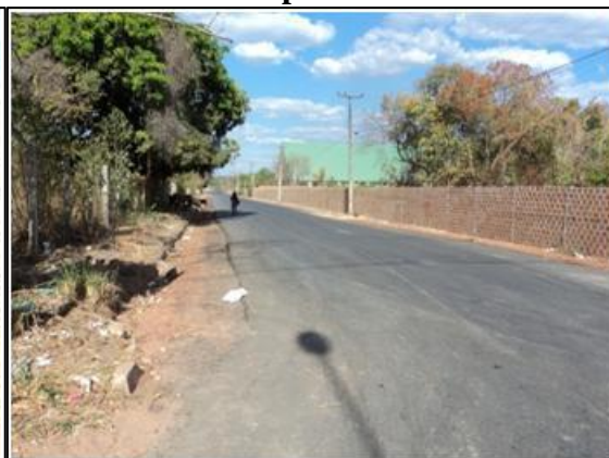
Foto 6 - Após o asfalto e o muro
